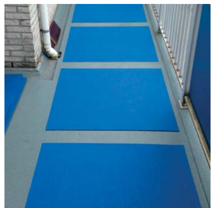
MONTAGE OP BETON
