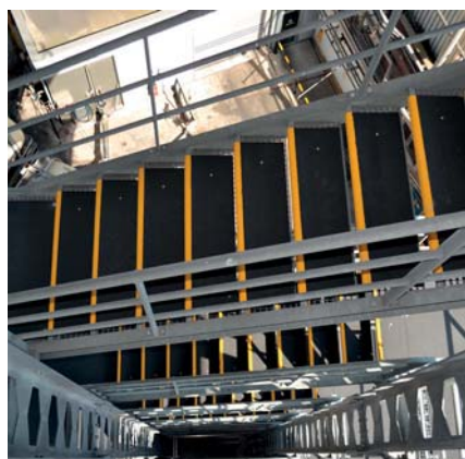
MONTAGE OP TRAPPEN
