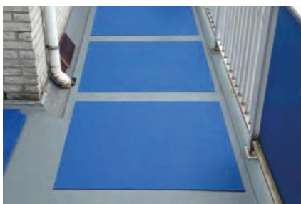
Montage op beton
